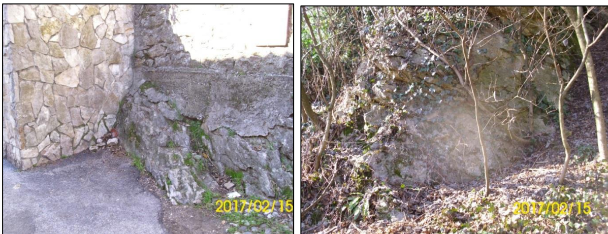
Figura 15 – Particolari affioramenti rocciosi alla base del muro
