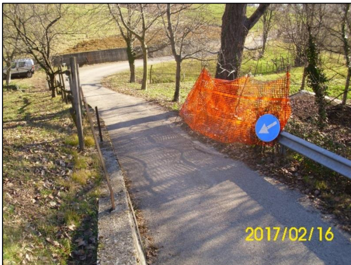
Figura 20 – Panoramica verso valle della strada oggetto di consolidamento
